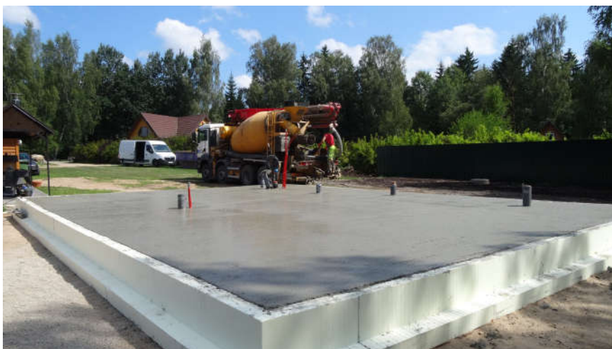
1. Att. Pamatu plātne ar inženierkomunikāciju izvadiem.
